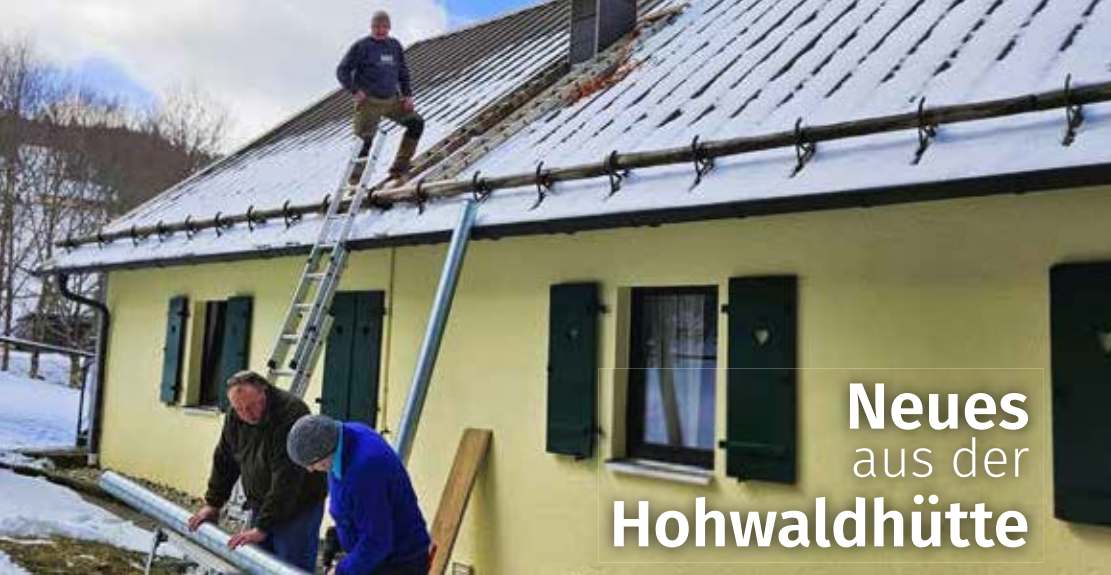
Montage der Lüftungsanlage
